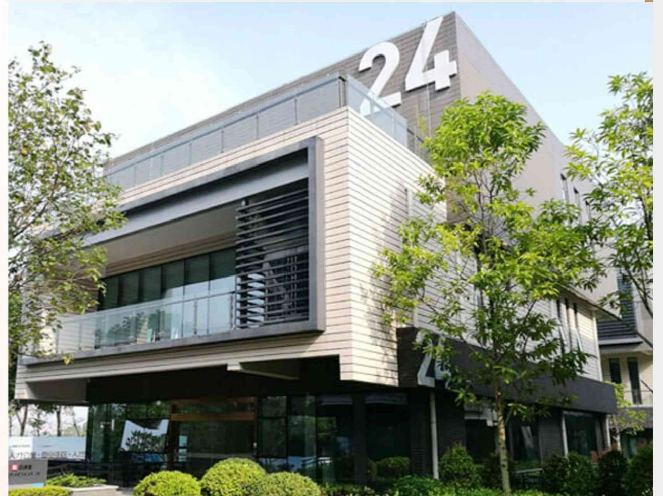
• 联科的百兑通总部大楼
